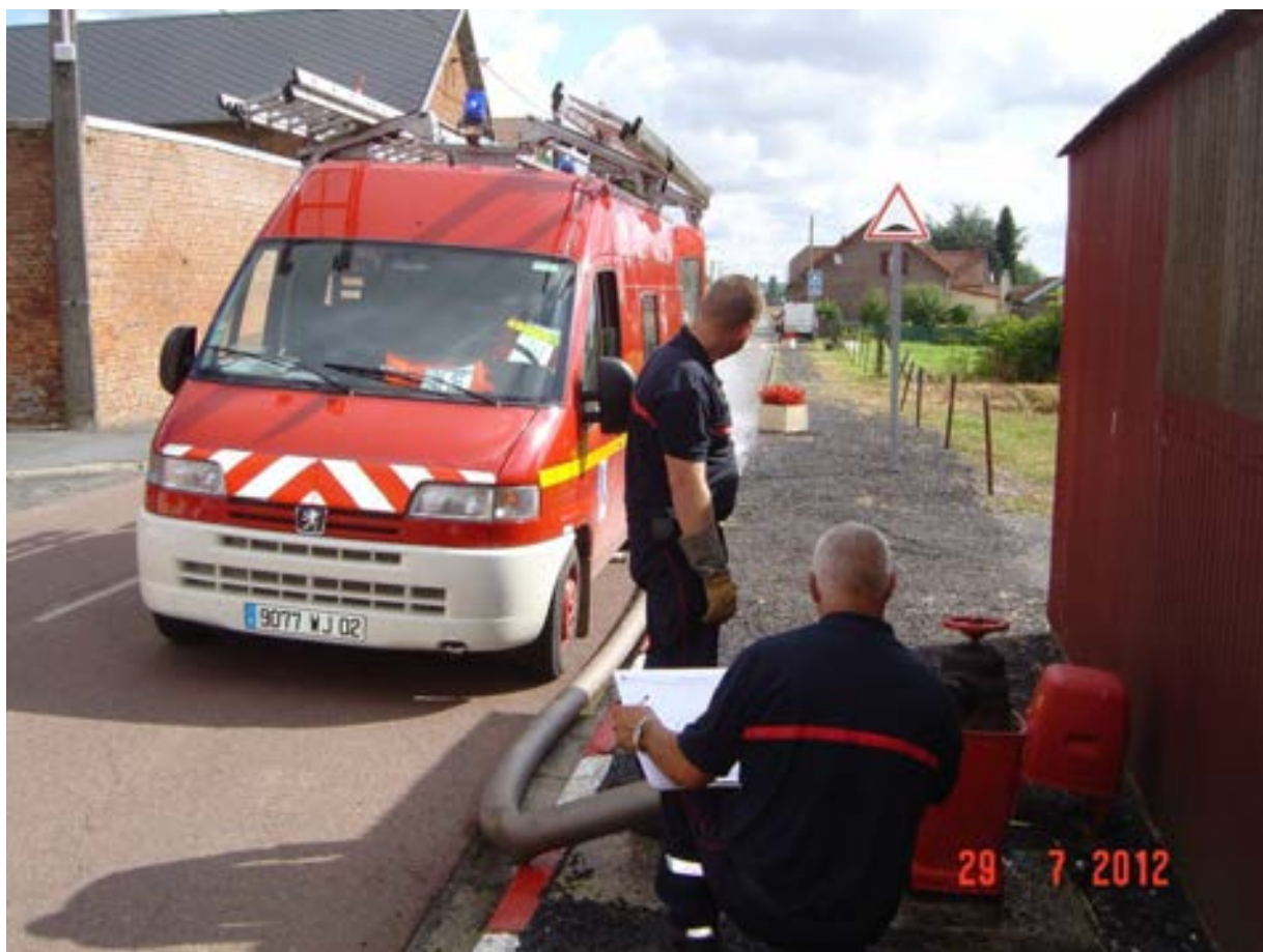
29 juillet 2012. Essai et contrôle des pompes à incendie.
