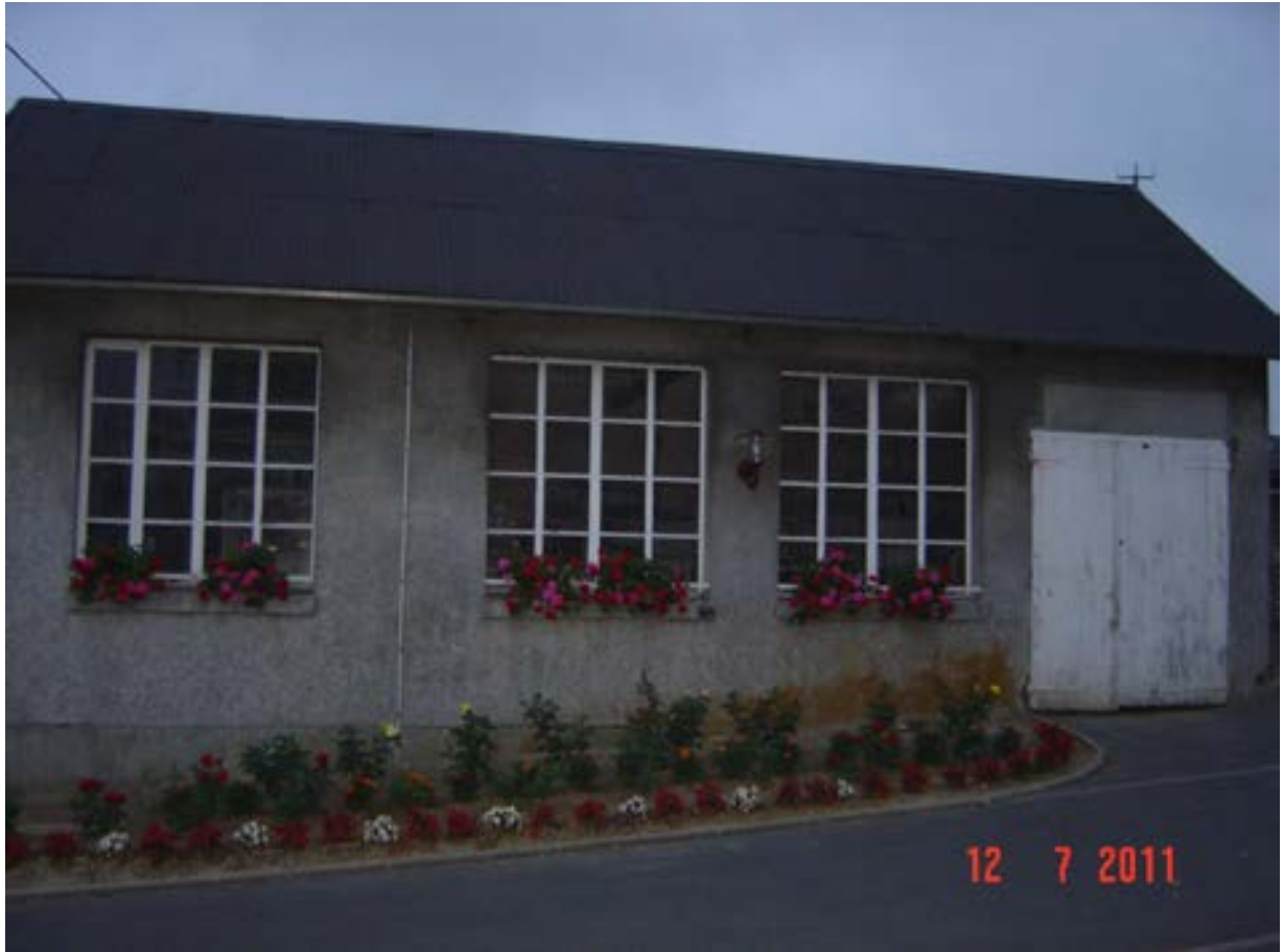
Menuiseries du bâtiment avant les travaux.
