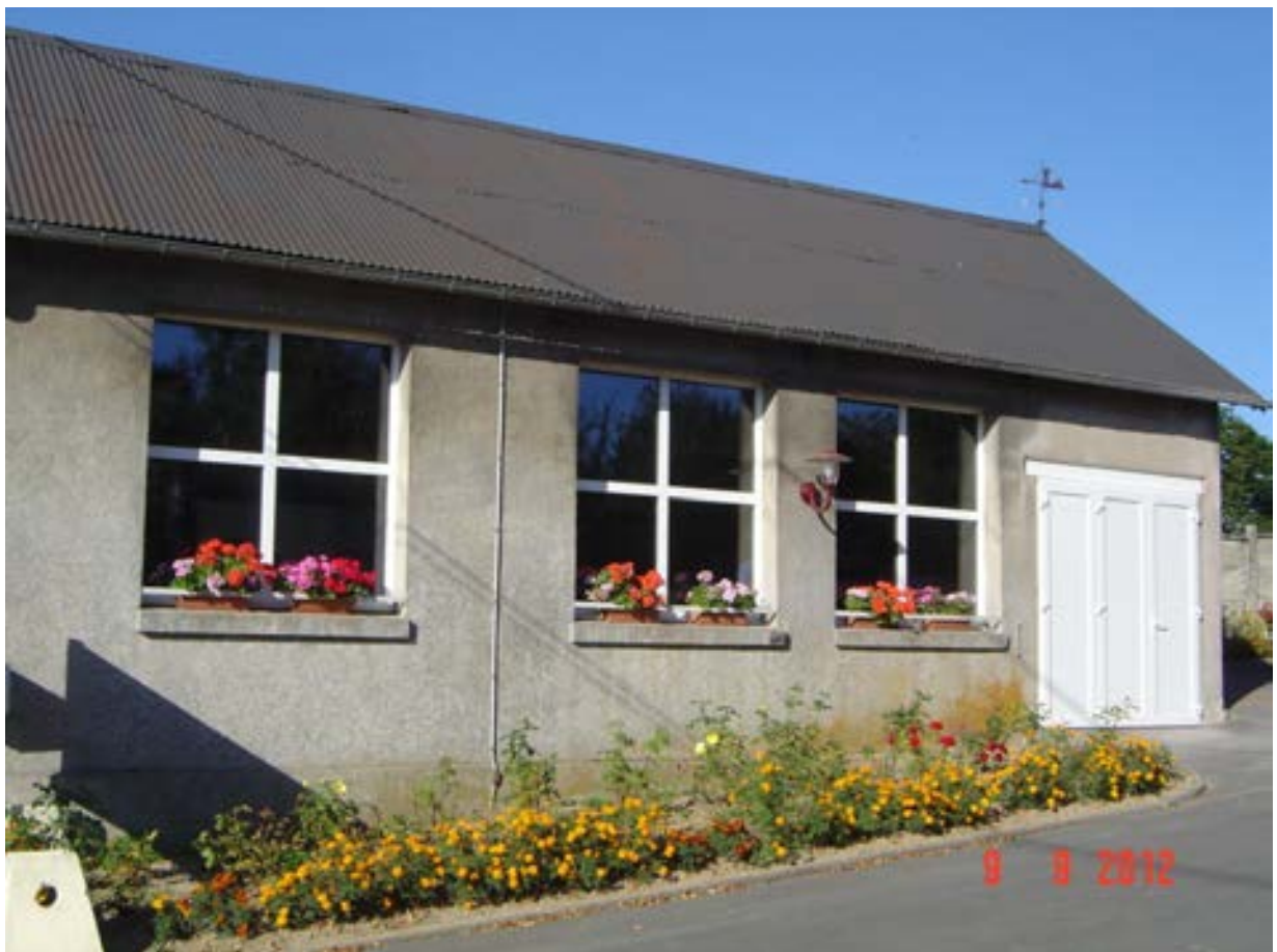
Menuiseries après les travaux réalisés par l'entreprise locale L.D.B
