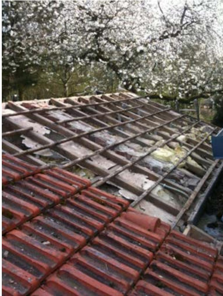
**Toiture des sanitaires du logement, en tuiles très abimées, pendant la dépose.**
