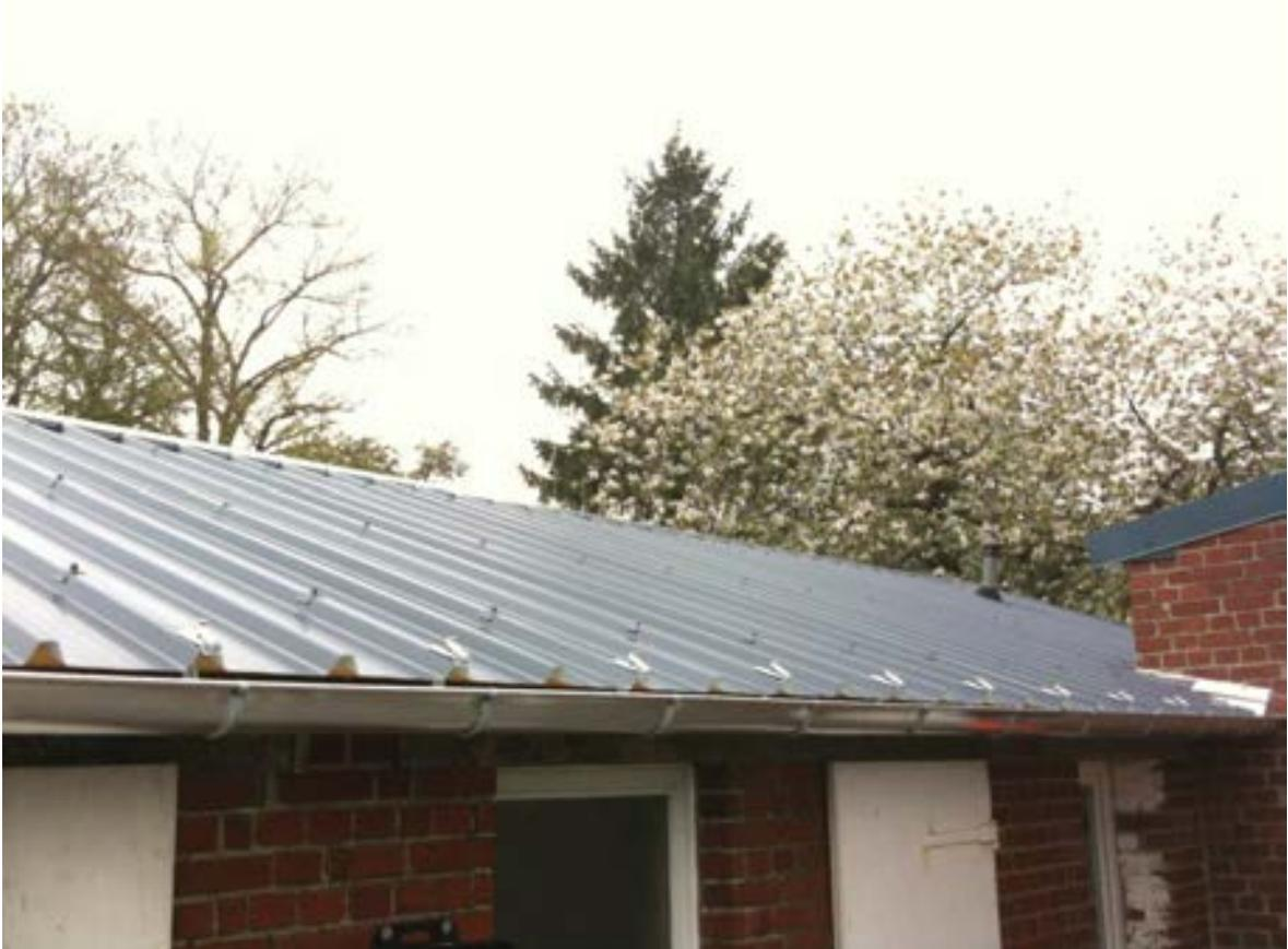
**Remplacée par une toiture bac-acier double peau isolante.
