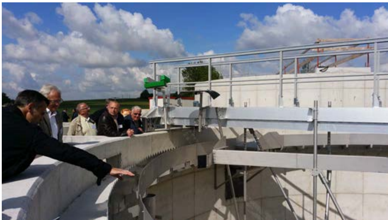
26 mai 2015. Explication du fonctionnement de la future station d'épuration.
