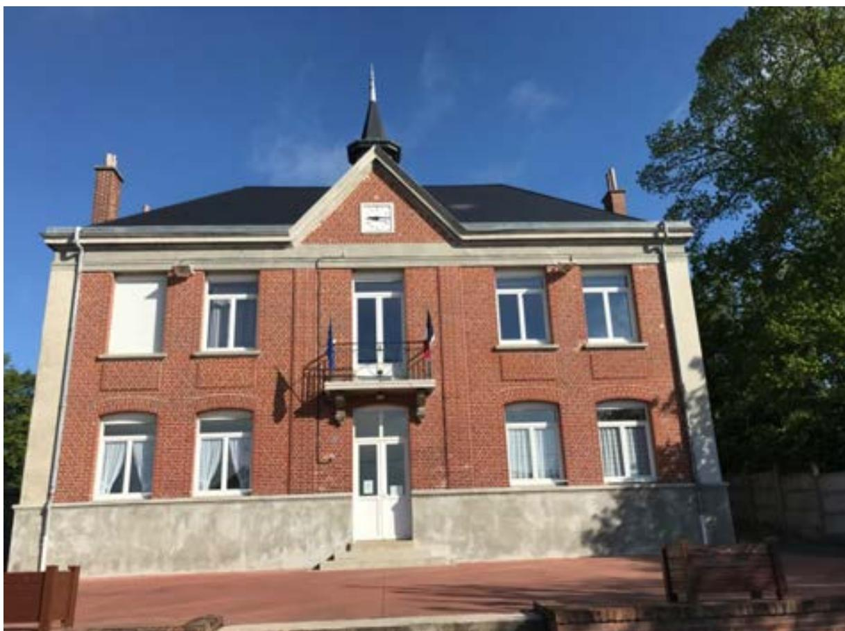
**Photo après l'intervention de démoussage, de traitement fongicide, pose d'un primaire et de 2 couches de résine. La toiture est désormais comme neuve, à moindre coût.**
