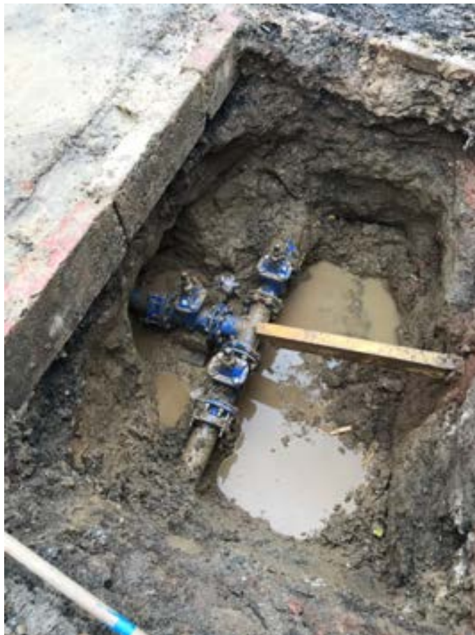
Maillage du réseau de diamètre 80 au réseau de diamètre 100 de la Grande Rue. Ceci afin d'augmenter le débit de la Rue d'En Haut.
