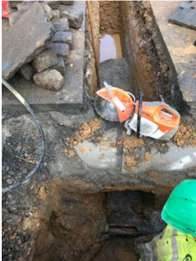
28/10/2020. Travaux de raccordement des réseaux d'eau de la Rue d'En Haut.
