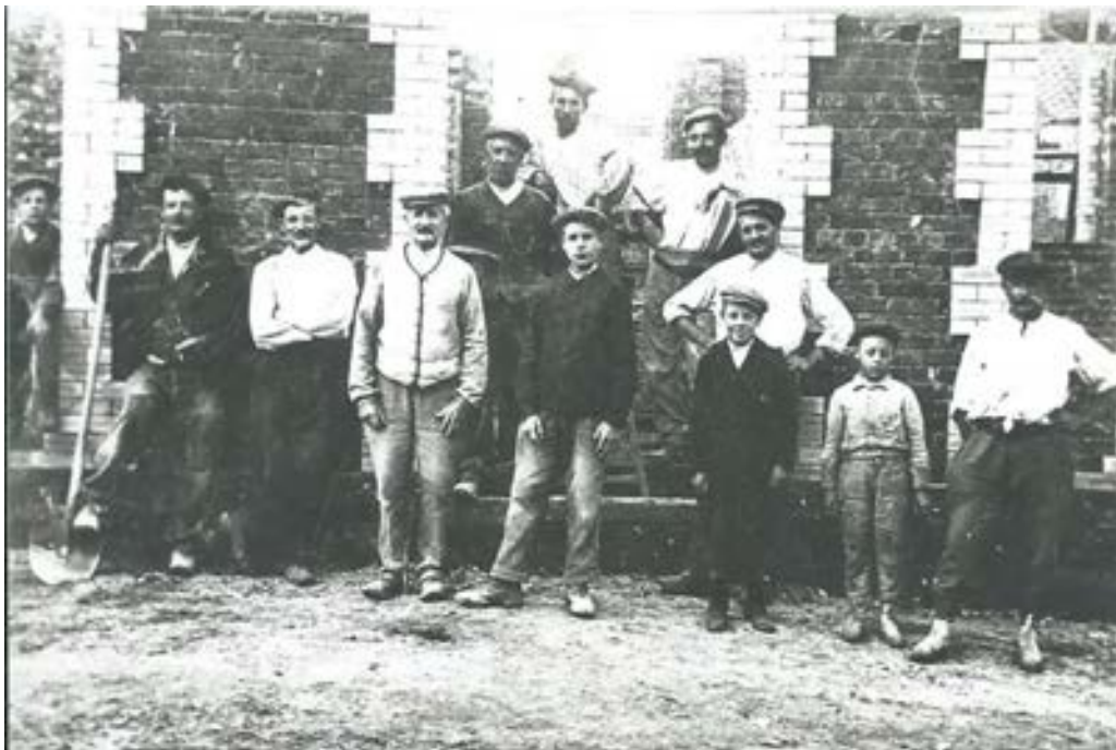
Ouvriers de la reconstruction
