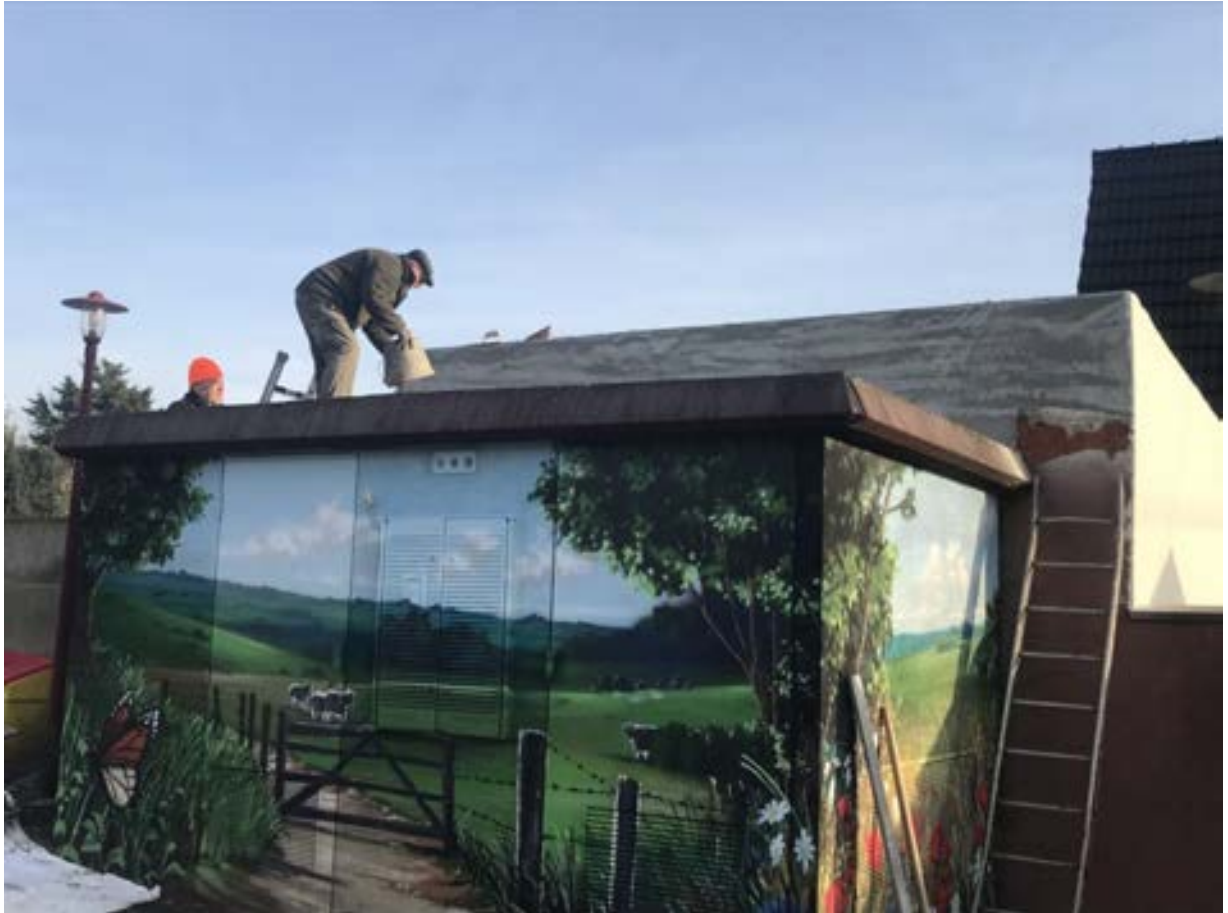
Février 2023, Jean-Paul, accompagné par Pierre et Thierry réalise un enduit couleur brique au dos du bâtiment voisin.
