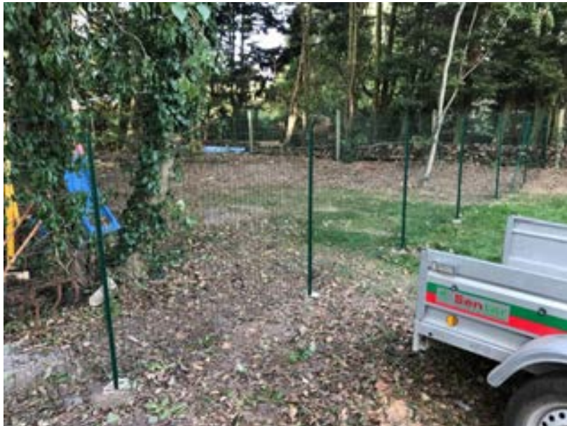
Pose d'une clôture autour du terrain jouxtant l'aire de jeux enfants.
