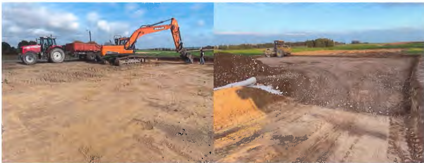
Création d'une aire de retournement des bus scolaires, pour des mesures de limitation des risques des manœuvres, et surtout de la sécurité des élèves. Décaissement, remblaiement avec matériaux compactés et liés.
