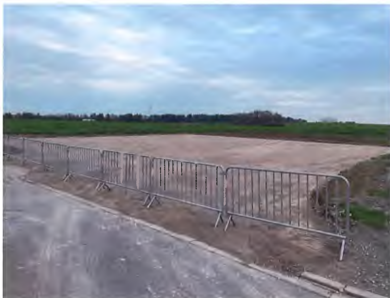
Pose d'un ternaire chimique, avant la pose de l'enrobé.
