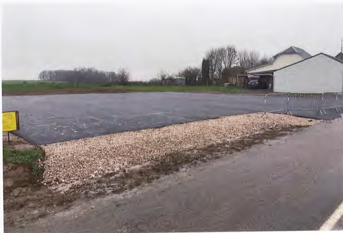
Pose d'un lit de gravier drainant.
