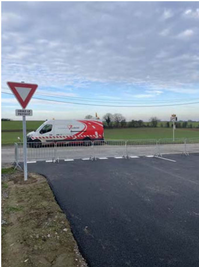
Pose de la signalisation horizontale et verticale pour l'aire de retournement.
